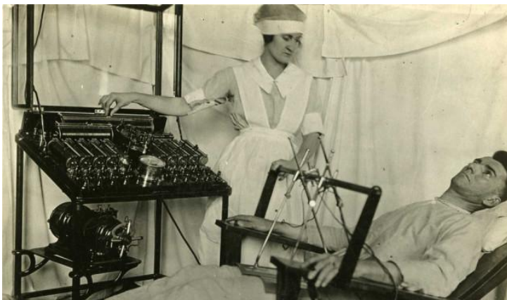
Esempio di trattamento elettrico
